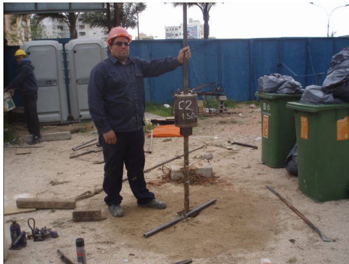
EN PUNTA MUESTRAEDOR, ROCA CRISTALINA ALTERADA
