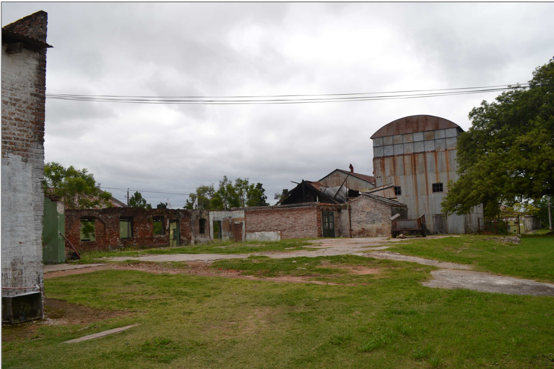
Figura 5.- Vista parcial (tomada desde el SW) de la zona de implantación del subsuelo.
