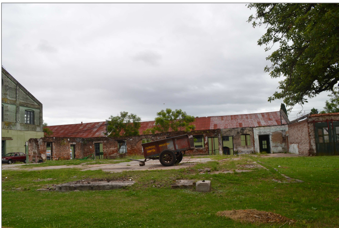
Figura 6.- Vista parcial (tomada desde el S) de la zona de implantación del subsuelo.
