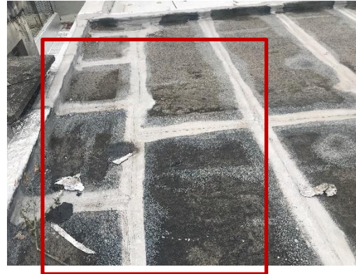
Sector afectado con mayor ampollamiento contra medianera
