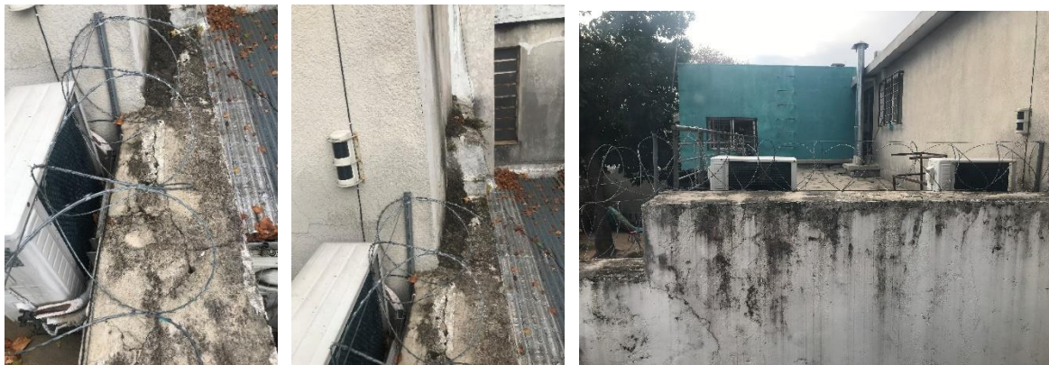
Estado de pretil de azotea, sobre local cocina y estado de la medianera que afecta se presume locales en cuestión.
