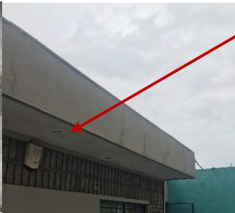
Bajo alero vestigios del ingreso de agua con ampollamientos, humedad y desprendimiento de revoque
