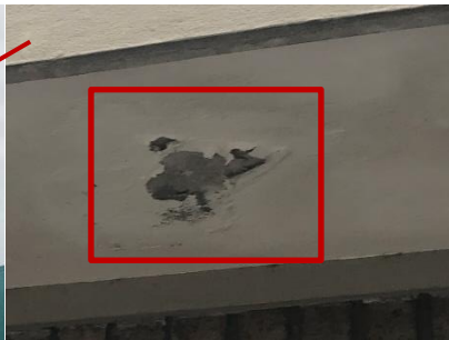
Bajo alero vestigios del ingreso de agua con ampollamientos, humedad y desprendimiento de revoque
