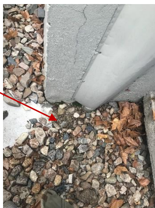
Desagüe Sin protección junto a puerta de salida azotea fachada
