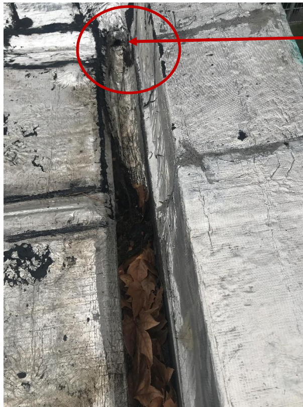
Desborde sobre fachada, prácticamente cerrado por la membrana.
