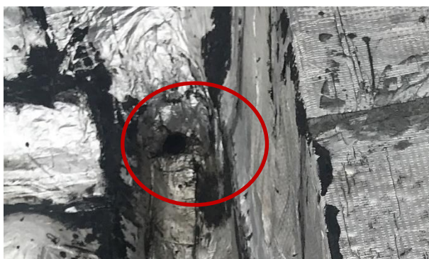
Desborde sobre fachada, prácticamente cerrado por la membrana.
