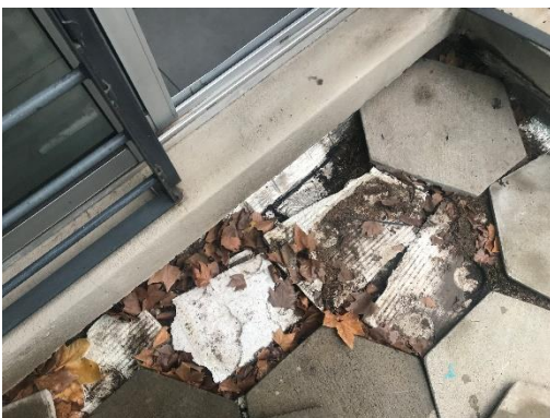
Exterior puerta de salida azotea fondo. Espuma trabante en pedazos.
