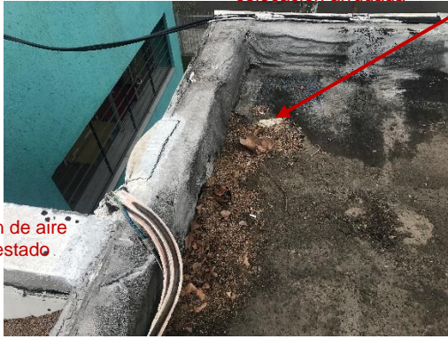
Sector desagüe tapado y membrana en pretils colocación arrugada
